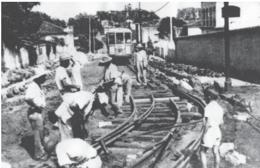
Construção dos trilhos do bonde, 1906.
