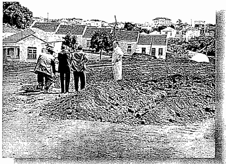
Cobertura da Canalização do Itapeva
