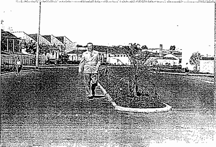
Prefeito Madrugador Luciano Guidotti vistoriando obras da futura Av. Armando de Salles Oliveira
