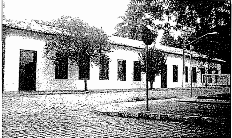
Figura 3. Casarão do Pau Preto, Indaiatuba, SP. Construção rural com implantação original em periferia urbana. Janelas numerosas providas de balaústres coloniais. Os cachorros foram eliminados.
