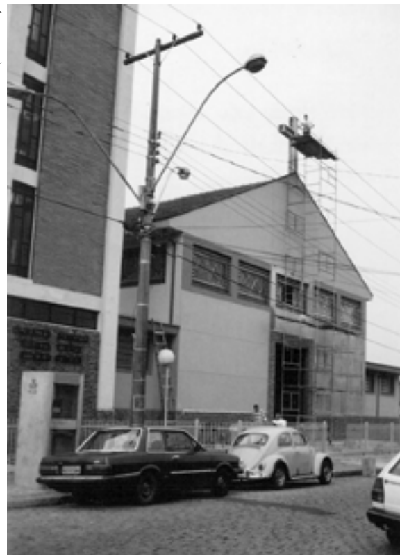
Aplicação de material na fachada
