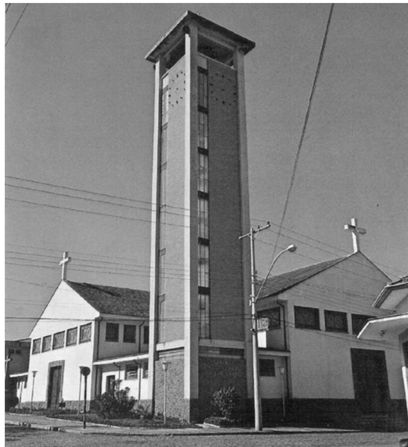
Torre da matriz concluída
