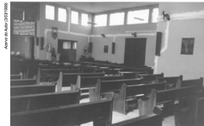
Interior do templo, período da reforma, localização dos eletrodutos
