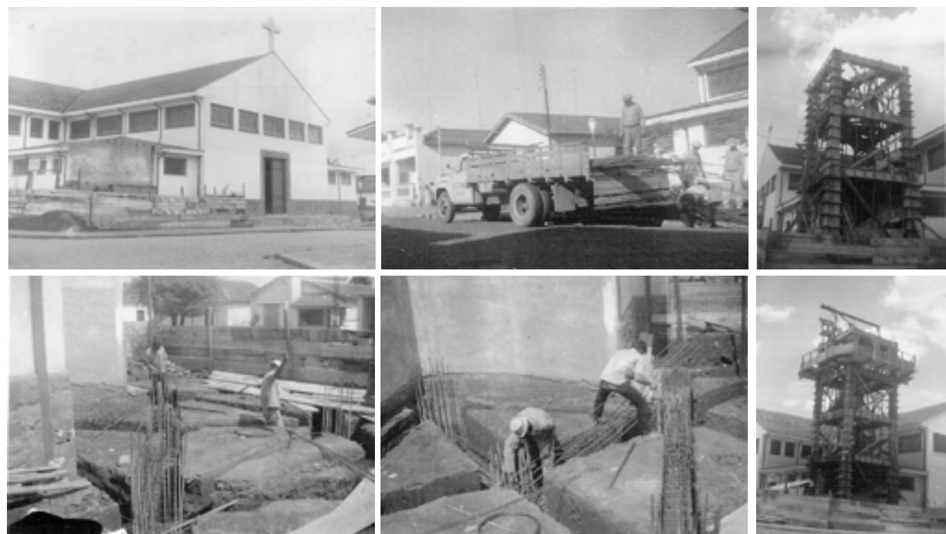
Construção da torre da matriz em diversas etapas: tapume cercando a área; descarregamento do material; terceira viga; fundações; malha de resistência; e quarta viga
