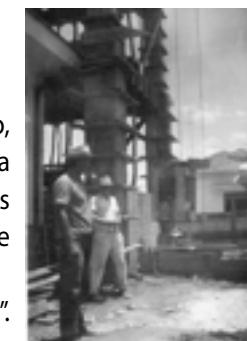
Pedreiros nas obras da torre
