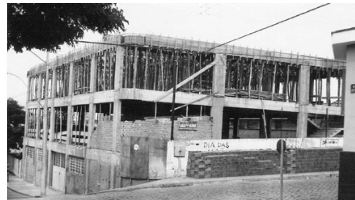
Fechamento da caixaria para a concretagem da terceira laje do Centro Paroquial, outubro/84
