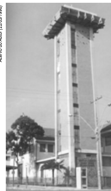
Reforma do campanário, andaime de proteção
