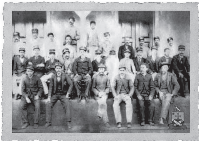
Operários da ferrovia Ituana
